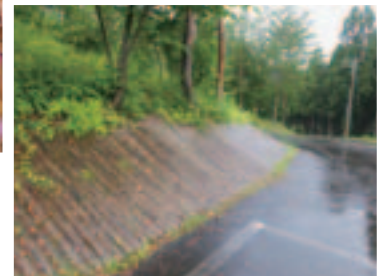
間伐材を使った工事用資材 (上:木柵、下:法面パネル)
