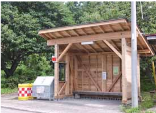
長岡市三島上条バス停 平成29年8月完成
